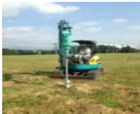
（設備設置のための調査）
